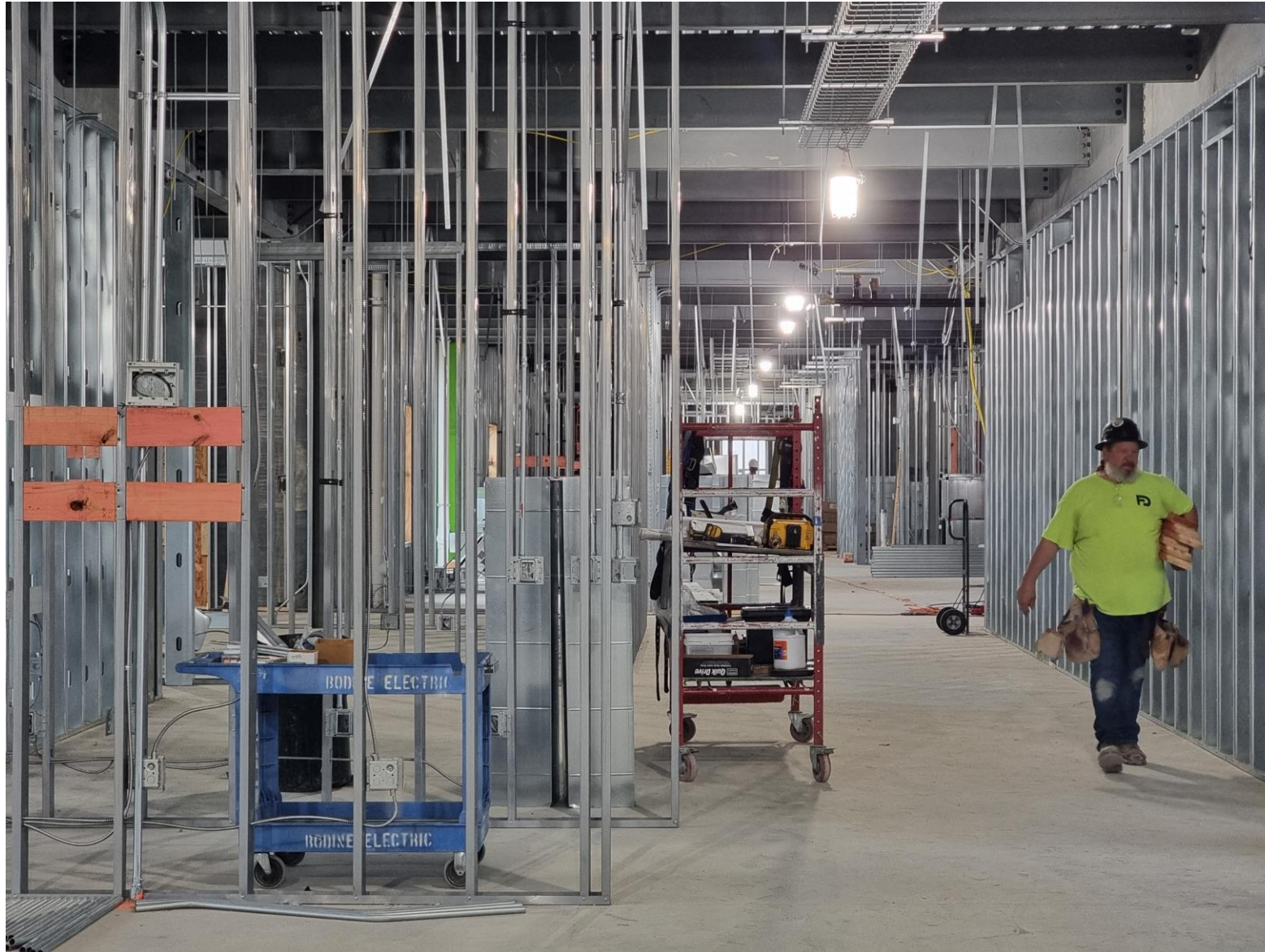
Interior Metal Stud Framing
